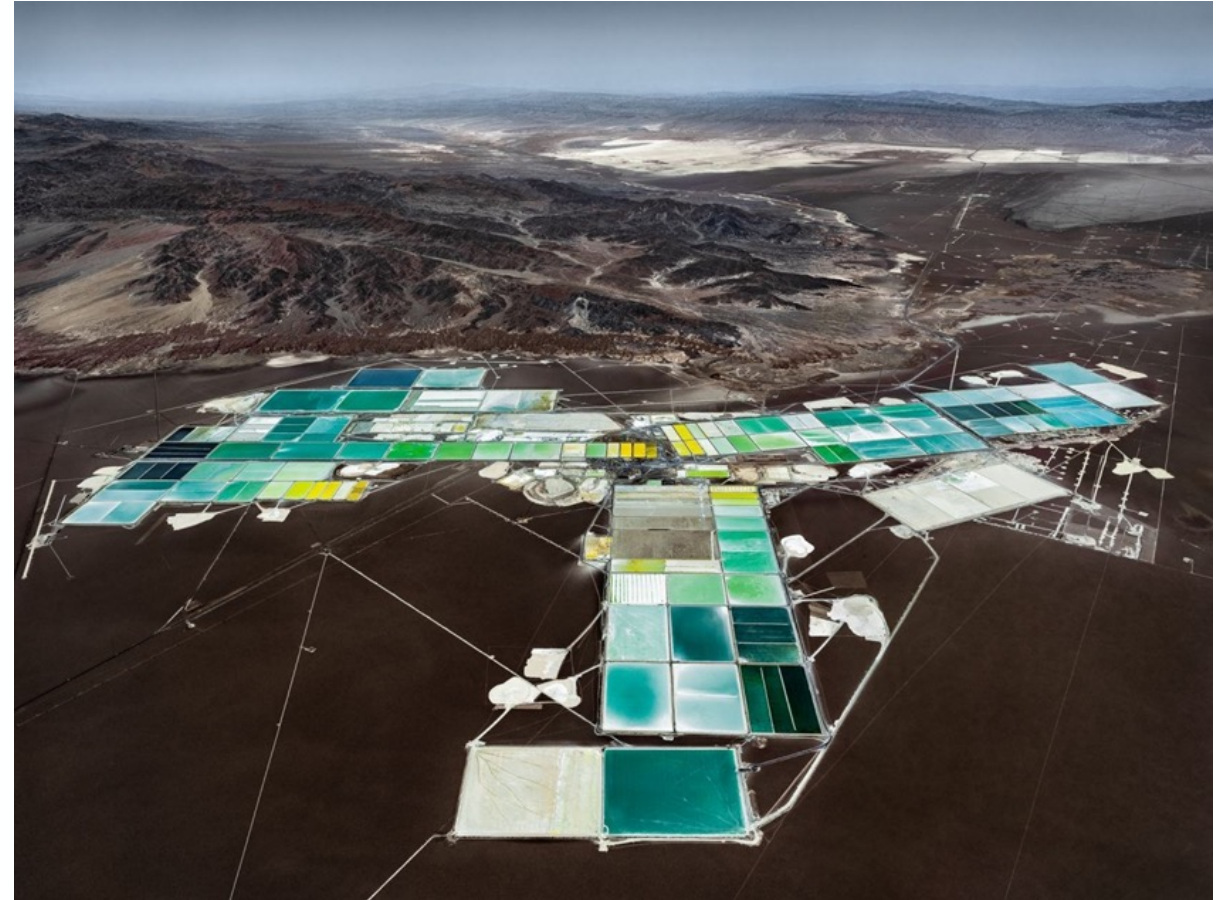
Vista aérea de la operación actual de Albemarle en el Salar de Atacama
