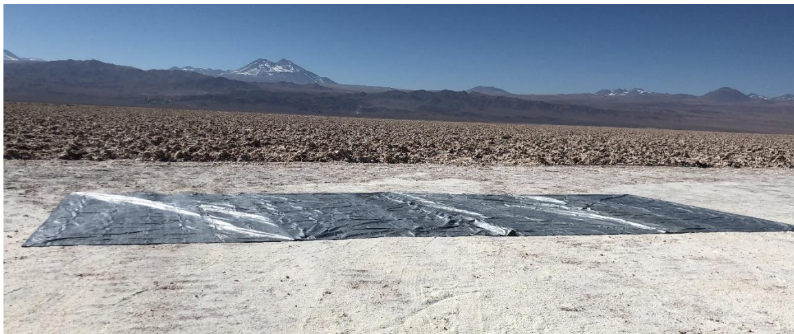
Instalación de pista de aterrizaje para UAV de ala fija
